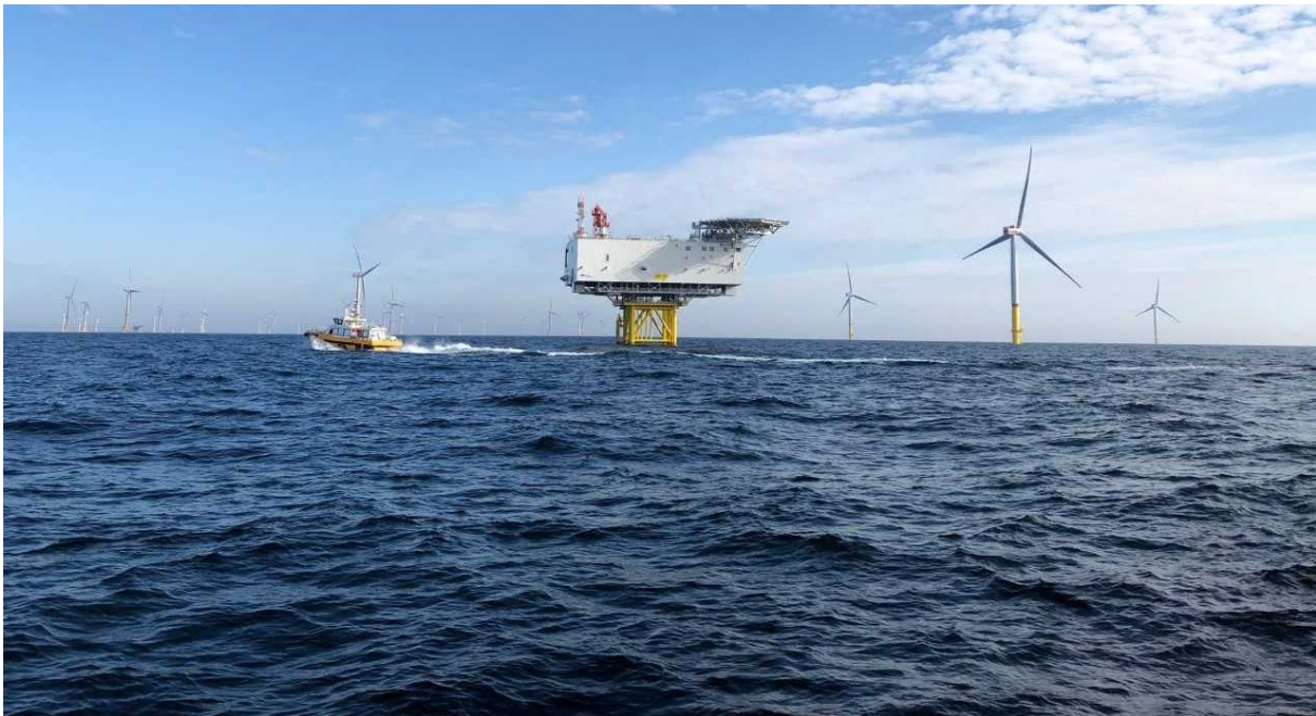
Vindkraftsparken Arkona, mellan Rügen och Bornholm, invigdes våren 2019 och har med sina 60 turbiner en installerad effekt på 385 MW vilket gör den till den största vindkraftsparken i Östersjön för tillfället.
